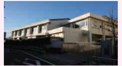
板二中体育館
