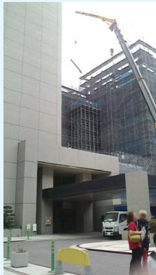
本庁舎北館・南館
